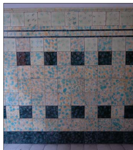
detail obkladu vstupu
